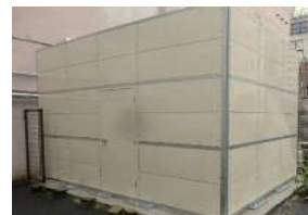
2面6段設置(扉付き)
