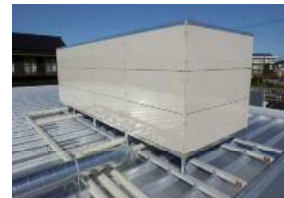
店舗折板屋根設置
