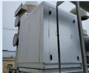
ポンプ用防音BOX
