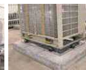
エアコン用防振架台
